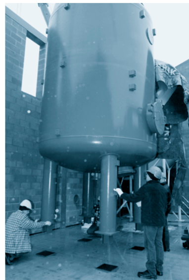
Einbau eines Entsäuerungsfilters auf der TWA Elsenborn
